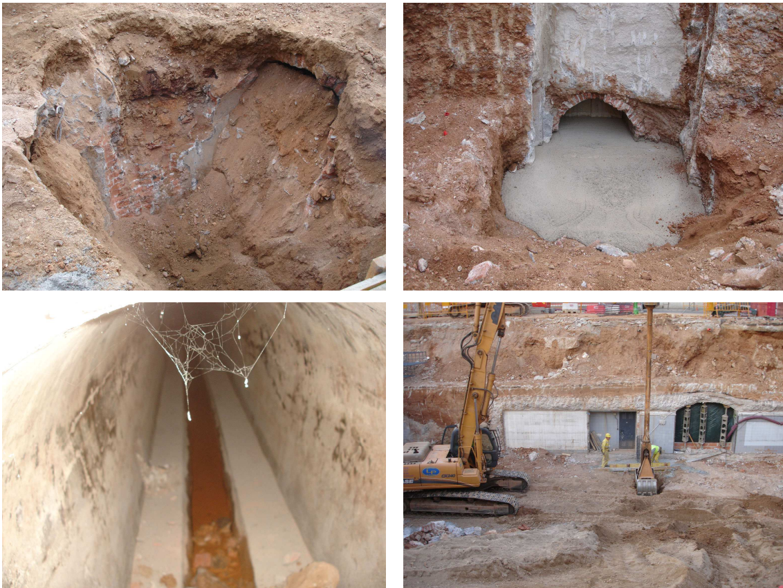
Vistes del col·lector afectat, del seu interior i dels treballs de realització de les rases.
