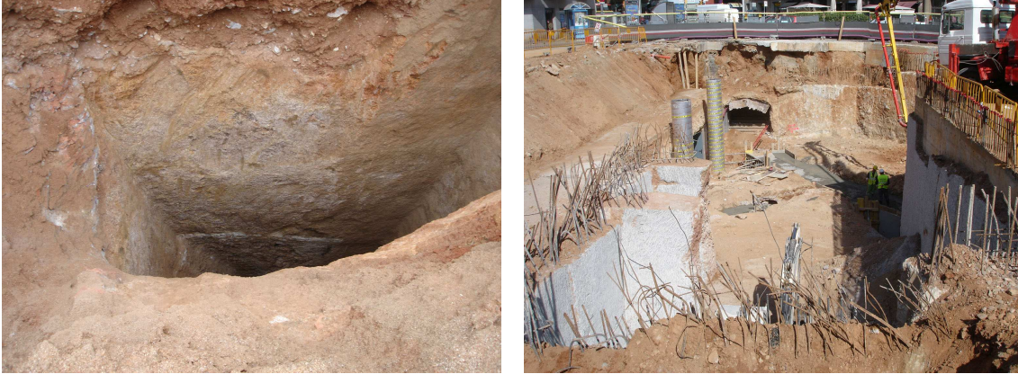
Vista d'una de les rases per a pantalles al fons de la cala 1 i vista final general de la cala 1 amb l'actual estació de Virrei Amat al fons a l'esquerra.
